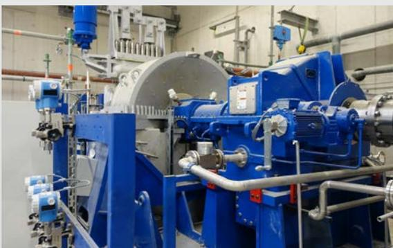
Die Dampfturbine im Agro Energiezentrum Rigi produziert Strom aus Holzenergie.
