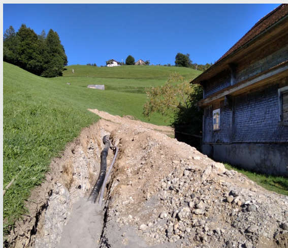
Die Fernwärmeleitung zur Wohnsiedlung Sonnenrain wird nach der Verlegung eingesandet.
