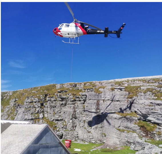
... die Anlieferung des Betons erfolgte mit dem Helikopter.
