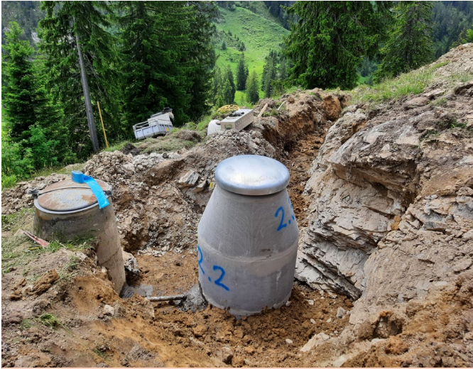
Sisigerboden, Riemenstalden: Neuer Triebschacht und Ersatz der Druckleitung für den Widder
