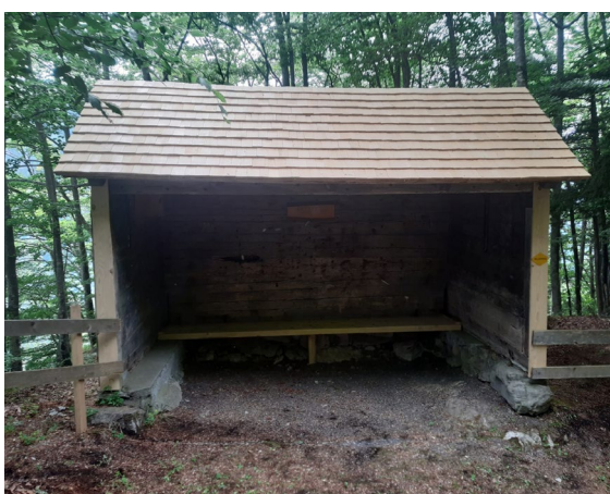
Sanierte Gruobi am Lintiweg, Illgau
