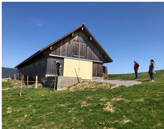
An der Südfassade des Alpstalls Balzengütsch wurden neue Schiebetore eingebaut ...
