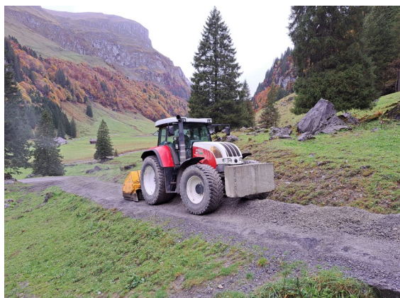
Strassensanierung Sahli bis Gross Gaden
