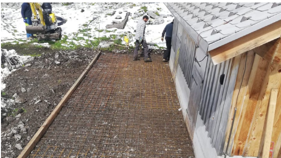
Die Betonarbeiten um die Charetalphütte wurden durch die Älplerfamilie ausgeführt, ...
