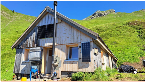
Bei der Alphütte Obergross wurde die Aussenfassade saniert und ...
