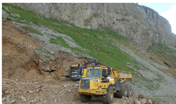
Kiesabbau im Gross Mälchtal für die Strassensanierung der Torstrasse
