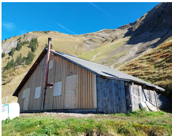
So zeigt sich die Alpütte Fläschen aussen nach der Sanierung ...
