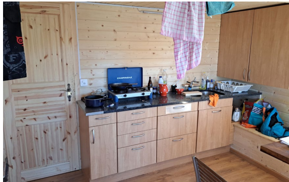
... eine neue Küche eingebaut.
