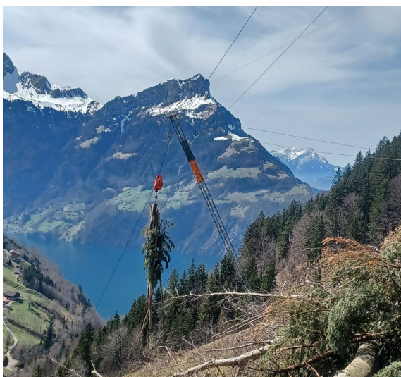
Konventioneller Seilkran im Einsatz, Obergadmen, Riemenstalden
