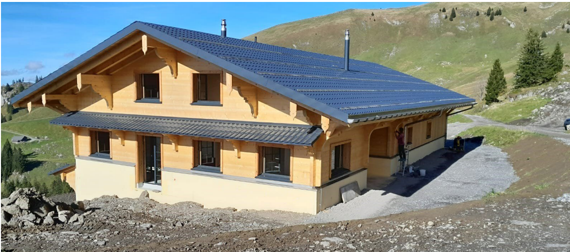
Die neu erbaute Alpkäserei auf Chäseren, Oberiberg, kann am Oberallmig-Alptag besichtigt werden.
