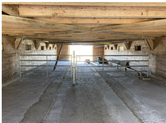
... und der Stallboden für Laufstallhaltung betoniert.
