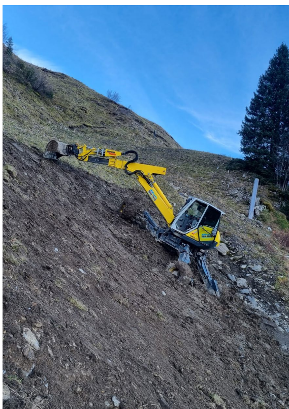
Der Starkniederschlag führte im Weidgang obere Guggernhütte auf Käsern, Oberiberg, zu einem Hangrutsch, welcher mit dem Menzi Muck wieder instand gestellt wurde.
