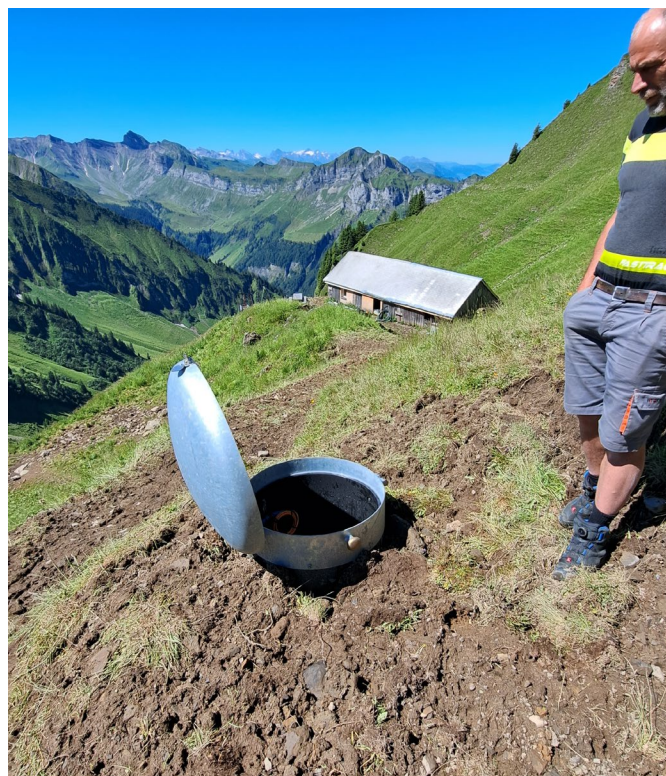
Wasserversorgung für die Alp Obergross mit Pumpschacht und neuem Reservoir
