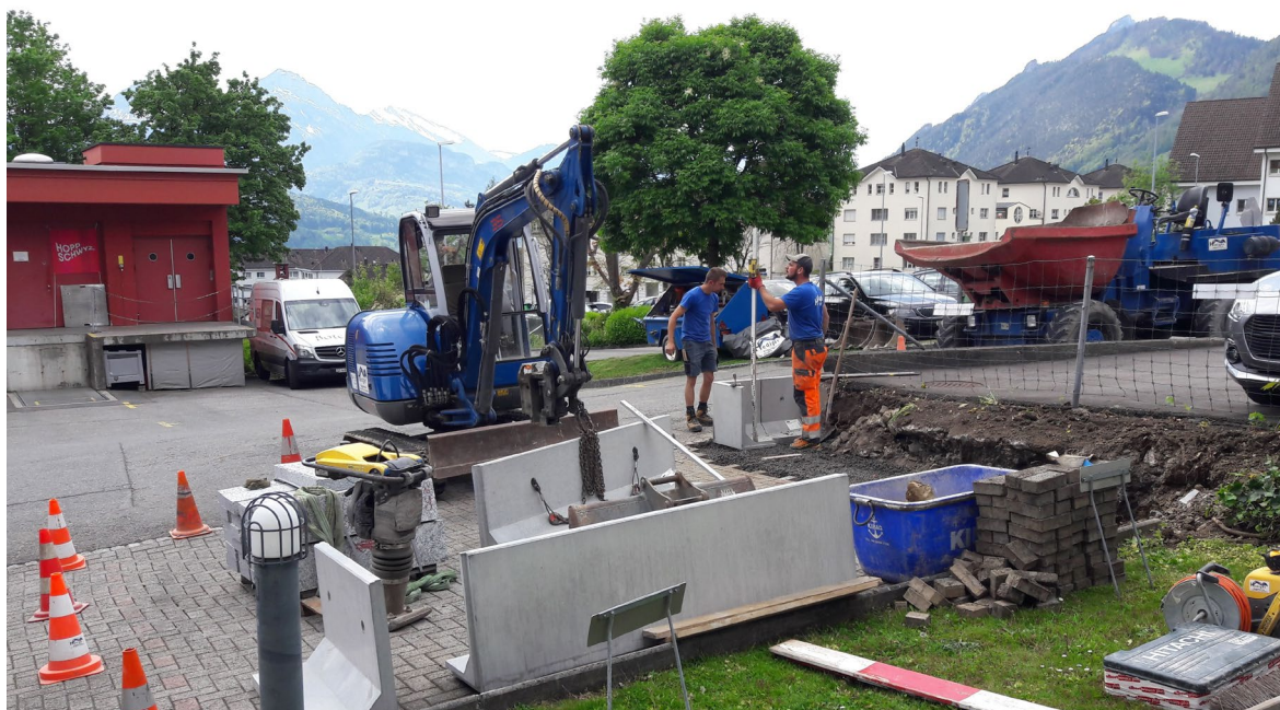
Brüöl 2-8, Schwyz: Sanierungsarbeiten bei den Parkplätzen
